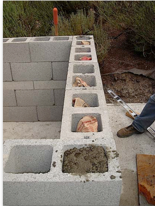
2.7. Filling the cores.
