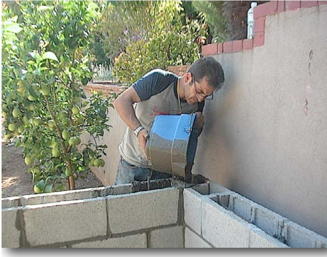
2.8. Filling the cores.
